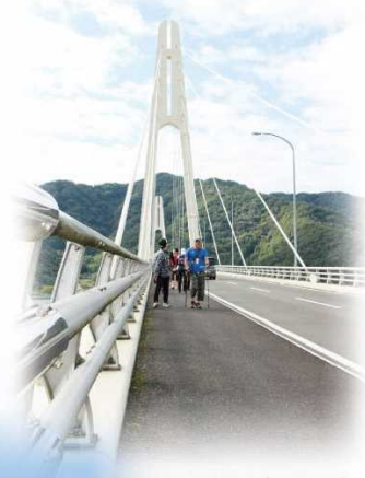
クレーンブリッジ
